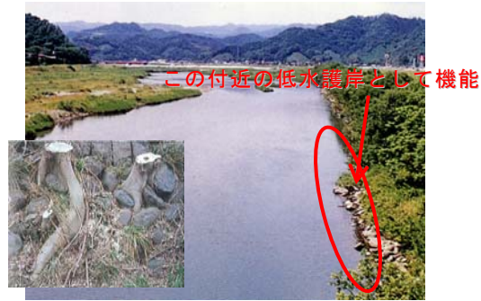
写真 1.2.1 護摩土手の法面の石積と見られる跡と石を抱き込んだヤナギの根(稲常橋上流)
