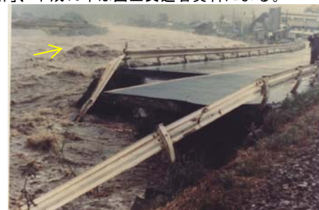
昭和54年10月18日洪水 浸食された道路(安蔵付近)
