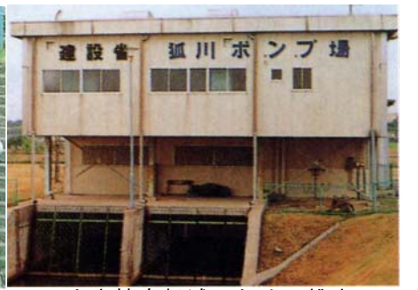
内水被害軽減のための排水ポンプ場の機器類の更新
