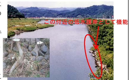
写真 1.2.1 護摩土手の法面の石積と見られる跡と石を抱き込んだヤナギの根(稲常橋上流)
