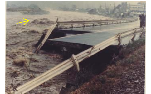
昭和54年10月18日洪水 浸食された道路(安蔵付近)
