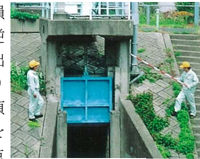
排水門の点検
