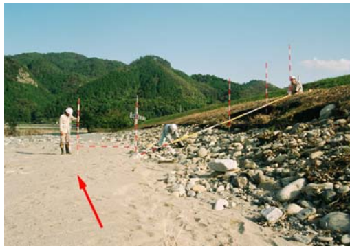
被災箇所の測量 (平成16年9月洪水：鷹狩付近)
