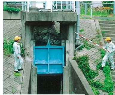
排水門の点検
