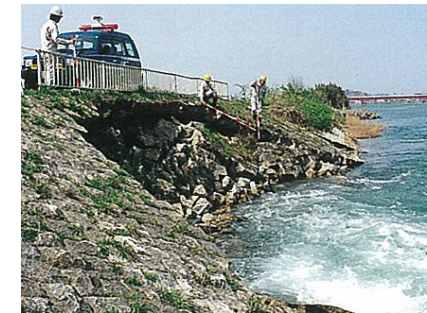
被災箇所の測量
