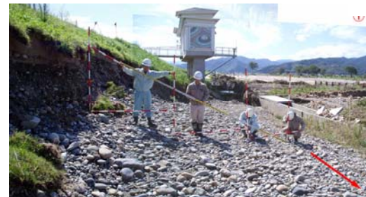
平成 16 年 9 月洪水による堤防の崩壊状況(倉田スポーツ広場付近)
