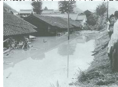
昭和34年9月26日洪水 水に沈んだ家屋(立川二丁目付近)
