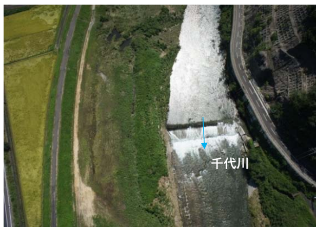
改修前(施工前) 旧八日市堰
