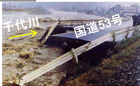
国道が侵食により流出(信用瀬町)
