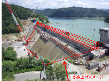
ダム建設・ダム再生
