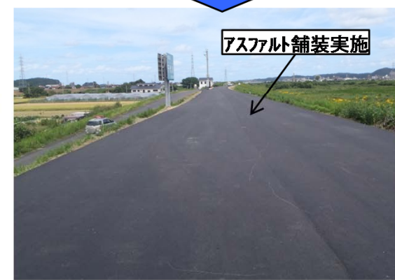
舗装後の堤防天端状況
