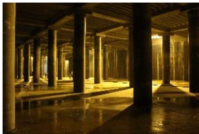
大規模地下貯留施設(下水道)
