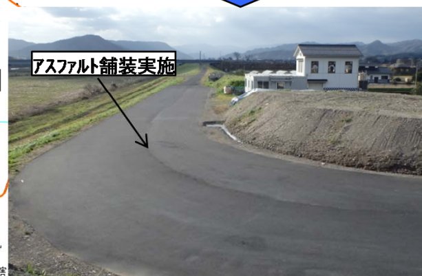
舗装後の堤防天端状況
