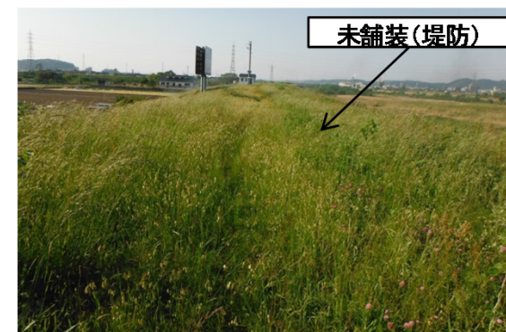
舗装前の堤防天端状況
