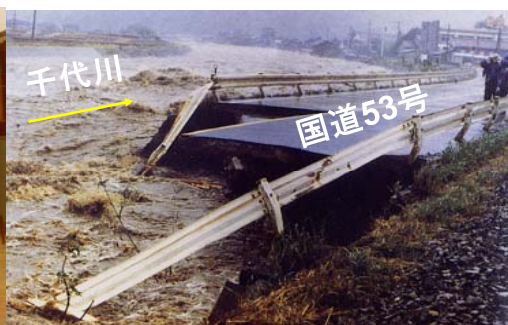
国道が侵食により流出(旧用瀬町)
