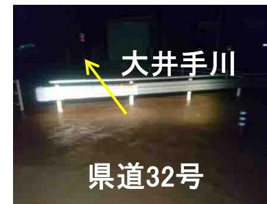
鳥取市下渡一木地区の浸水状況
