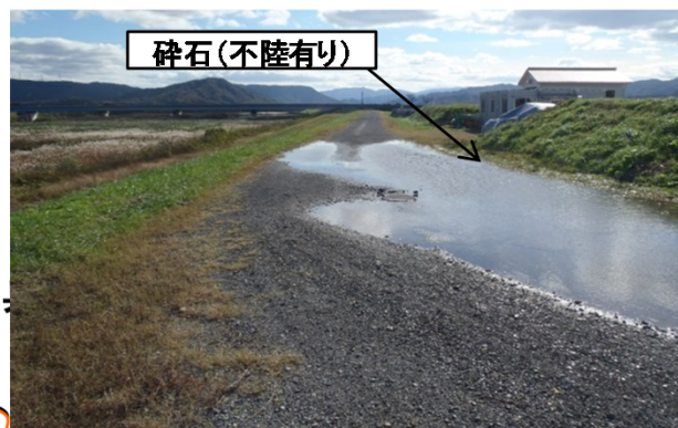
舗装前の堤防天端状況
