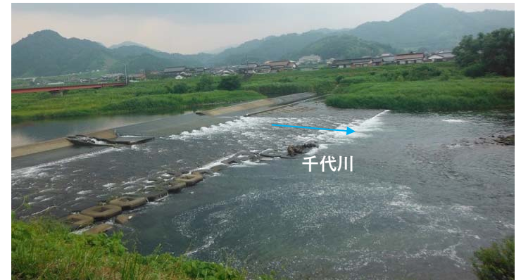
改修前 (施工前)
