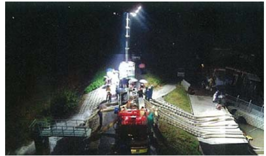
照明車と排水ポンプ車
