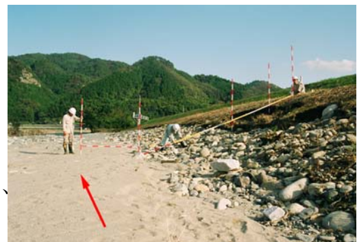
被災箇所の測量
