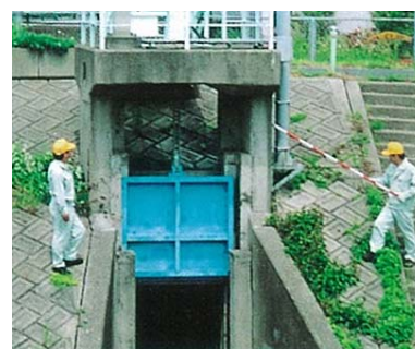
排水門の点検状況
