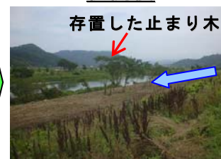
鳥類の休息場に配慮した樹木伐開の例 (間引き伐開: 千代川左岸10.0k付近)
