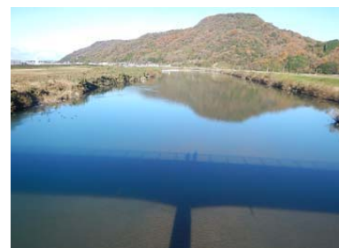
稲常橋上流付近
