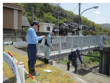
写真 5.2.7 排水樋門の点検
