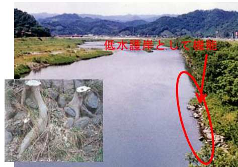
写真 1.2.2 護摩土手の法面の石積と見られる跡と石を抱き込んだヤナギの根(稲常橋上流)
