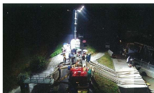
写真 5.2.8 照明車と排水ポンプ車
