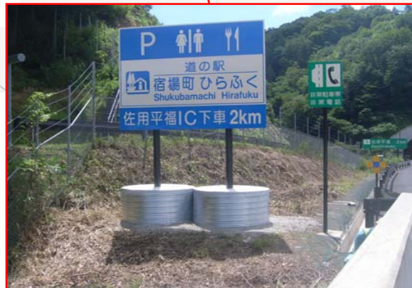
道の駅出口案内標識 ノーズ手前2km(上り)
