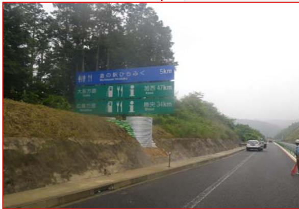
道の駅出口案内標識 ノーズ手前3km(上り)
