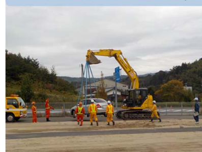
バックホウによる吊り込み移動
