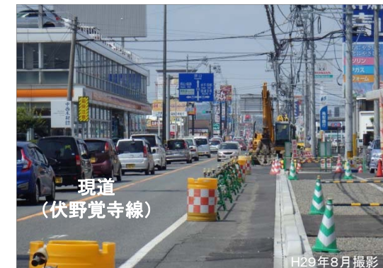
写真2 工事状況(安長北交差点向き)
