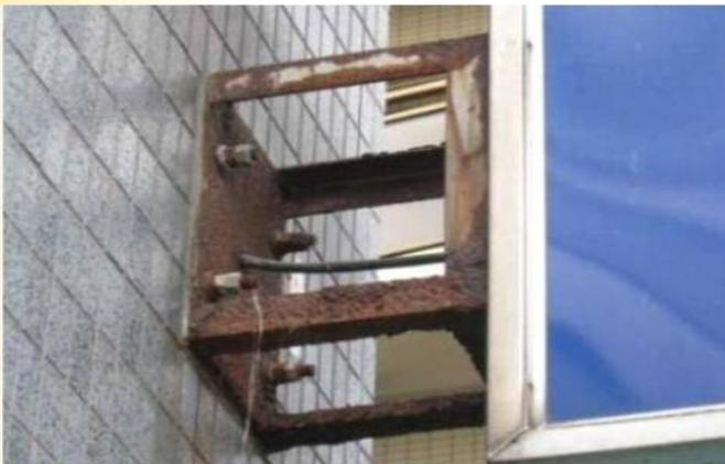
ブラケットの腐食による落下の危険のある看板
