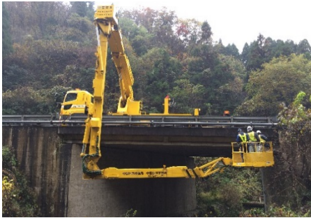
橋梁点検状況
