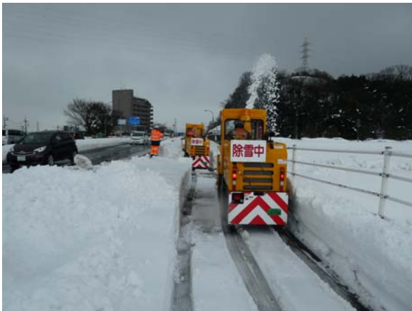
歩道除雪状況
