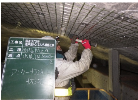
トンネル補修中
