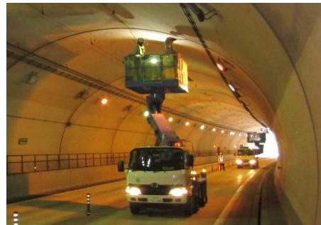
トンネル点検状況
