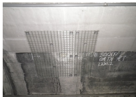
トンネル補修後
