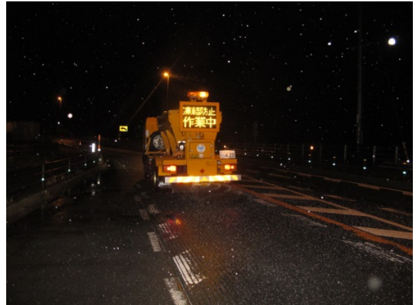
凍結防止剤散布状況
