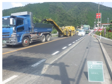
舗装修繕状況
