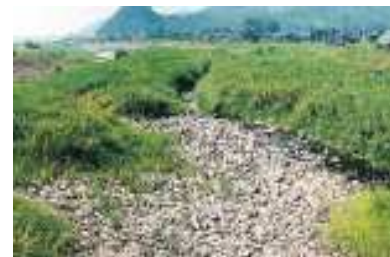
平成18年8月 鳥取市玉鉾橋付近(ダムなし)
