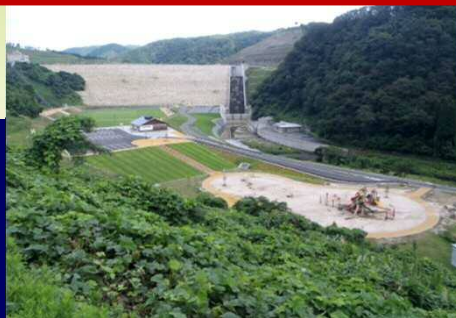
殿ダム記念広場(市)H25完成
