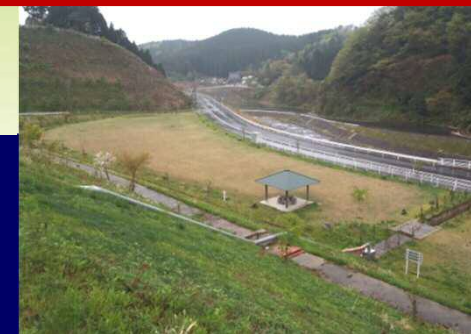
殿ダム親水広場(市)H25完成
