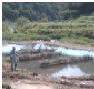
沈砂池には竹の小枝でしきりを作り、砂や泥の他ゴミも除去して、上澄みを川に流している。
