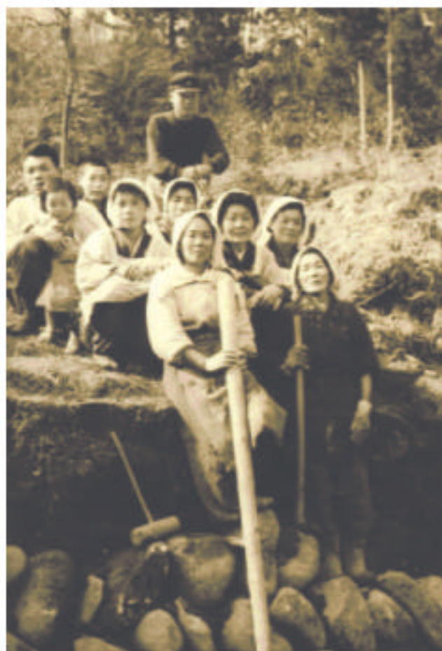
田んぼの石垣を構築中と思われる、昭和35年の写真。人々は人力で、石垣を造り、雨による土地の流失を防いできた。[写真提供：米山喜久さん]
