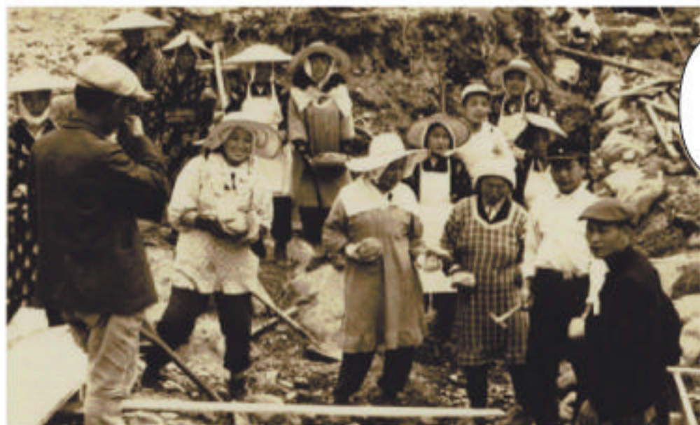
護岸整備を拾石地区の人々が行なっているところと思われる、昭和30年代の作業風景。この頃、まだダンプカーやショベルカーはなく、作業はすべて人力だった。[写真提供：米山富久さん]
