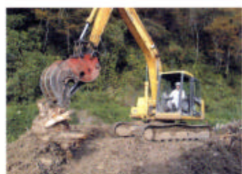
伐採した木や掘り起こした根を1箇所に集めます。
