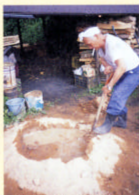
⑨ まさ土を水で練り、窯の口をふさぐレンガのつなぎの土を作る。
