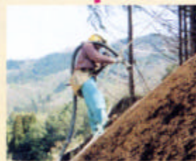
堆肥化した土をのり面に吹き付けている作業。
