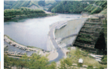
アーチ式コンクリートダム
