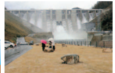
重力式コンクリートダム
