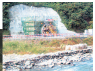
殿ダム仮排水路工事
