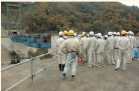
かんこ 殿ダム神護橋上部工事の現場見学の様子
