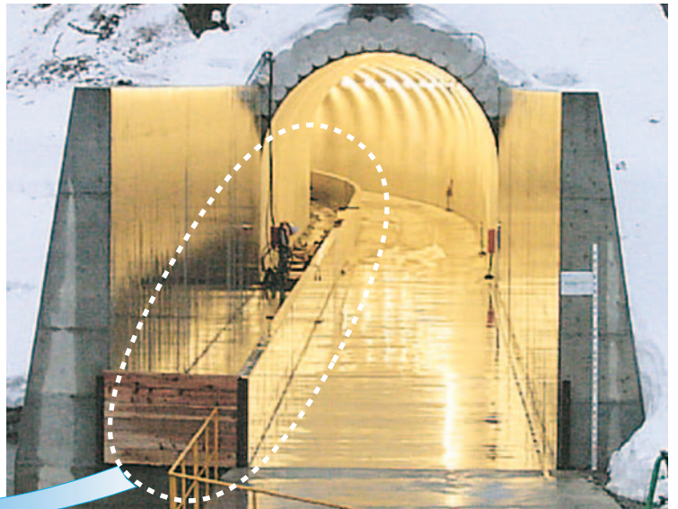
完成間近な仮排水路トンネル
