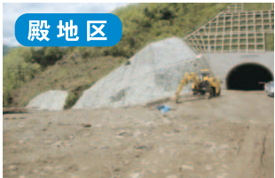
殿地区 殿ダム 右岸ダムサイト進入路工事 県道からダムサイト右岸への進入路工事です。
