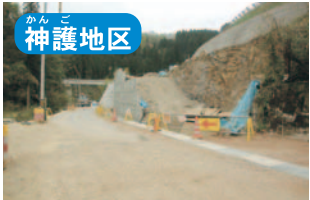
かんご地区 殿ダム 神護地区取付工事 付替市道(神護地区)の付替工事です。
