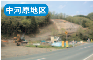
中河原地区 殿ダム 中河原地区県道付替(その2)(その3)工事 県道(中河原地区)の付替工事です。
