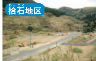
しっこく地区 殿ダム 河川付替(その2)工事 現在流れている河川をダム工事のために事前に横へ切り替える工事です。
