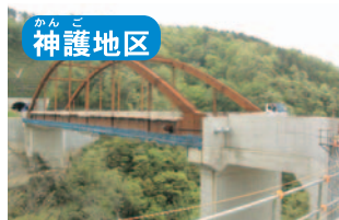
かんご地区 殿ダム 神護橋外床版工事 神護橋の床版というコンクリート(舗装の下面となる部分)の施工を行っています。
