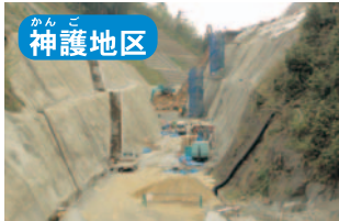
かんご地区 殿ダム 古神護土捨場進入路法面(その2)工事 古神護土捨場の進入路に法面対策を行っています。
