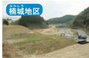
なわしろ地区 殿ダム 楠城地区県道付替工事 県道(楠城地区)の付替工事です。
