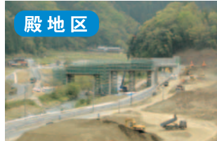
殿地区 殿ダム 殿橋上部工事 県道取付部のコンクリート橋の上部工事を行っています。
