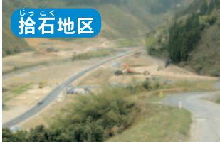
しっこく地区 殿ダム 河川付替(その1)工事 現在流れている河川をダム工事のために事前に横へ切り替える工事です。
