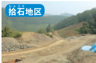
拾石地区 殿ダム 原石山進入路(その2)工事 ダム本体の材料となる石(骨材)を採取するための進入路を造ります。
