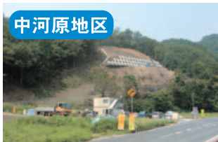
中河原地区 殿ダム 中河原地区県道付替(その2)工事 県道(中河原地区)の付替工事です。
