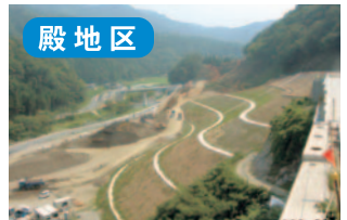
殿地区 殿ダム 殿地区県道付替(その6)工事 県道(殿地区)の付替工事です。
