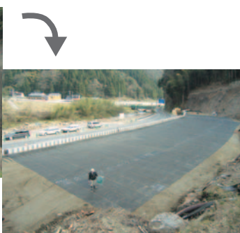
②盛土補強材を敷いた風景
