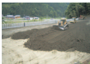
①土をならす作業風景
