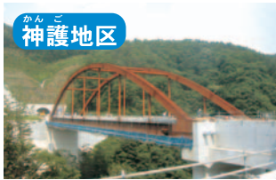
神護地区 殿ダム 神護橋外床版工事 神護橋の床版というコンクリート(舗装の下面となる部分)の施工を行っています。
