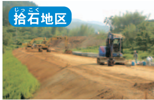
拾石地区 殿ダム 拾石地区県道付替(その7)工事 県道(拾石地区)の付替工事です。
