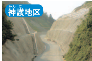
神護地区 殿ダム 古神護土捨場進入路(その2)工事 古神護土捨場の進入路に法面対策を行っています。
