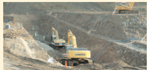
上流仮締切を造るにあたり、岩盤線まで掘削している作業風景。
