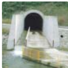
仮排水路トンネル
