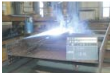
溶接作業の様子
