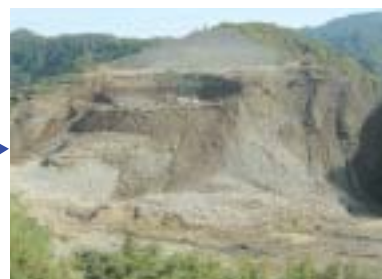
付替県道から眺めた殿ダム本体工事現場の様子。①地点を掘削し、出てきた土石をブルドーザーで下に落とします。②地点に落とされた土石は、ショベルカーを使い46トンダンプに乗せ運びます。
