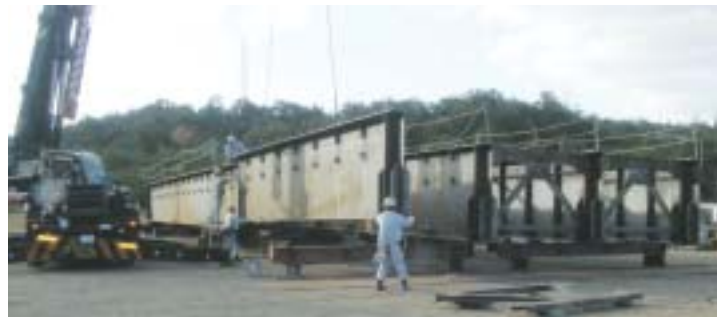
仮組立作業の様子
