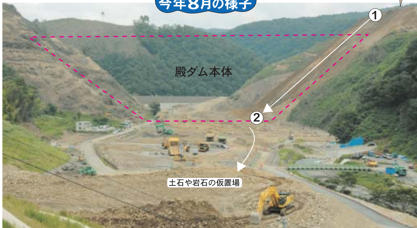
付替県道から眺めた殿ダム本体工事現場の様子。①地点を掘削し、出てきた土石をブルドーザーで下に落とします。②地点に落とされた土石は、ショベルカーを使い46トンダンプに乗せ運びます。
