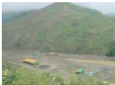
殿ダム本体工事現場の移り変わり
