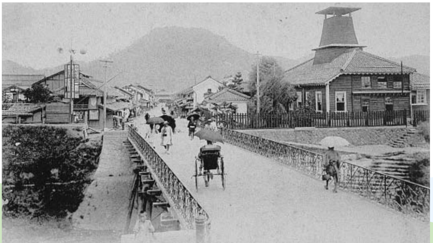
明治末期頃の智頭橋 木の橋脚で橋を支えていたことがわかる。右上の建物は鳥取警察署で、火の見櫓にはお寺の釣り鐘が取り付けられ、この鐘で時を告げていた。(写真提供:鳥取県立博物館)
