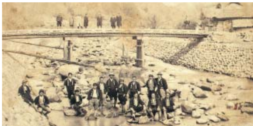
袋川上流の河川改修工事 鳥取市国府町下木原地内で行われた河川改修に携わった人とその関係者。(撮影:昭和11年頃。写真提供:山本鉄夫さん。情報提供:岡本徳美さん。)
