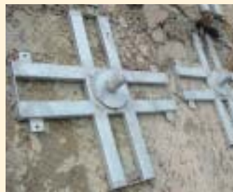
▲鋼製受圧板 ▼プレキャスト受圧板
