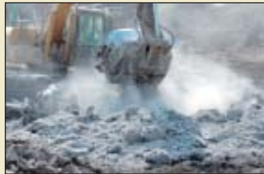
泥のたまり場に古紙を入れショベルカーで混ぜた後、セメントを入れ込み、さらに混ぜます。
