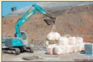
袋に入っている物はセメントで、泥の量を確認・計算し、必要最小限のセメントを使用します。
