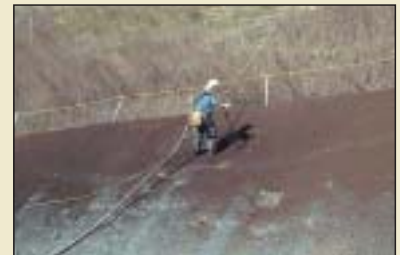
堆肥化した木は法面（掘削工事によりできた人工的な斜面）に吹き付け、緑化しやすい土にします。
