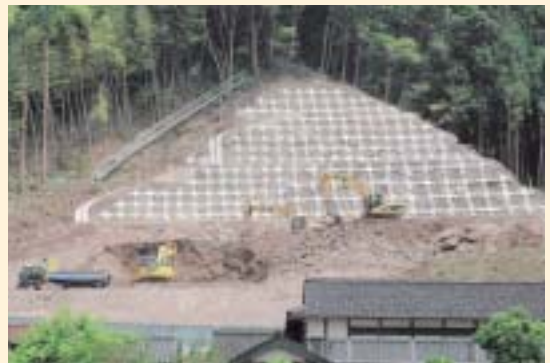
鉄筋挿入工を施工している作業風景。法面は一気に掘削すると危険なため、2段階に分け掘削し、安全性を保ちながら作業を行っています。
