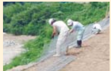
植物の種子を付着させた壁面材を設置します。
