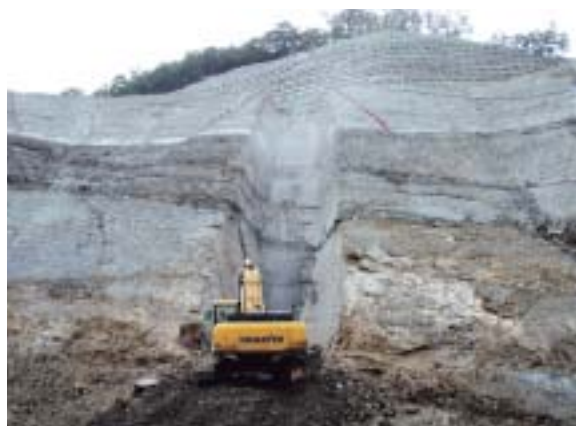
今年の10月下旬頃まで掘削工事を行なうため、展望台から監査廊のルートを見ることができます。
