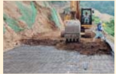
土砂を敷き均します。
