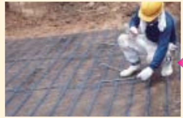
ジオグリッドを敷き、アンカーピンで固定します。
