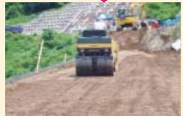
振動ローラーで均等に圧力をかけ強固な地面にします。
