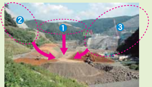
①原石山、②③基礎掘削ズリなどから材料を採取しています。
