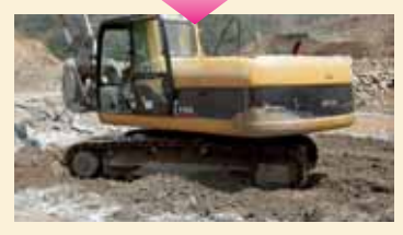
ショベルカーが乗っても沈まない強度のある土へ再生
