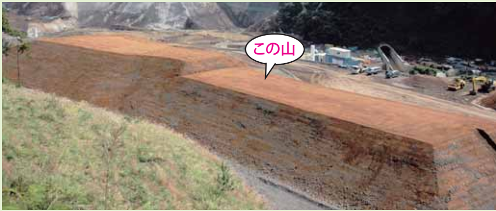
殿ダム本体工事現場(平成20年10月10日撮影)
