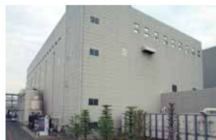
3階建のこの建物の中はすべて水のろ過装置が入っており、約15,000m 3 の水が循環しています。
