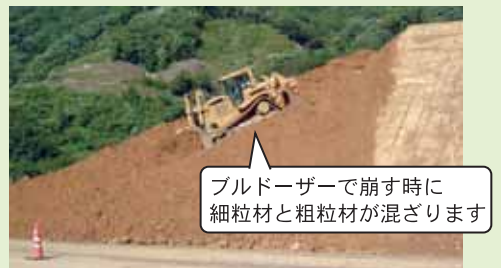
材料の切り崩し状況(イメージ)
