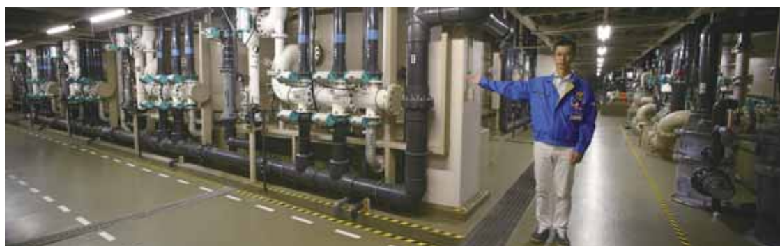
水の中に含まれる不純物を取り除くためのろ過装置の数々。泉孝治さんにご案内いただきました。
