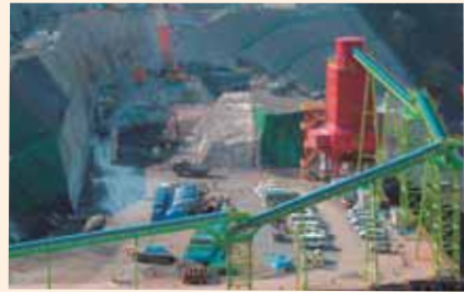
現場に建設したバッチャープラント
