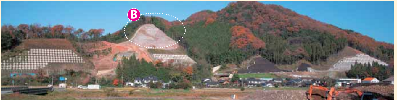
松尾集落付近から見た付替県道工事の様子(撮影:平成20年12月)
