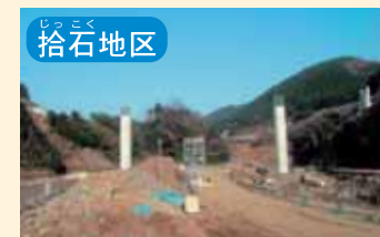
④ 貯水池横断橋下部工事 県道と楠城山崎線を結ぶ貯水池横断橋(仮称)の橋をのせるための台(橋台)と橋脚2基を造りました。
