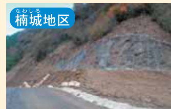
③ 楠城山崎線付替(その6)工事 市道楠城山崎線を付け替える工事です。
