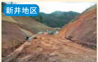
① 新井地区 県道付替(その3)工事 現道との接続部分で県道の付替工事を行っています。
