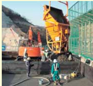
コンクリートを打つ作業風景
