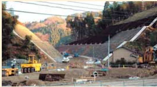
A 現道と付替県道の合流地点(新井地内)の工事風景。(撮影:平成20年12月)
