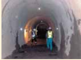
放流管を設置する取水トンネル
