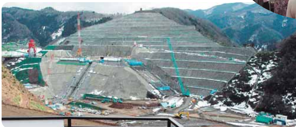
展望台から一望できる殿ダム工事現場
