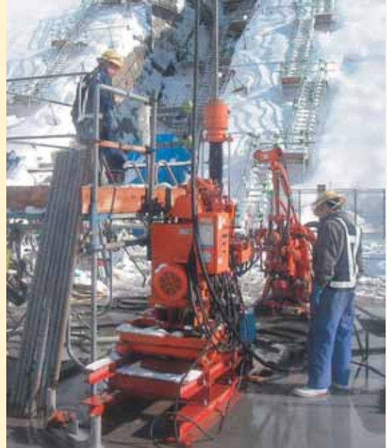
現場の作業風景(平成21年1月撮影)
