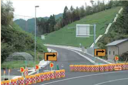
A 付替県道の起点付近の様子 (撮影:平成 21年6月)
