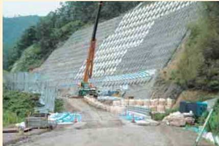
B 大山根橋付近の法面工事の様子 (撮影:平成 21年6月)
