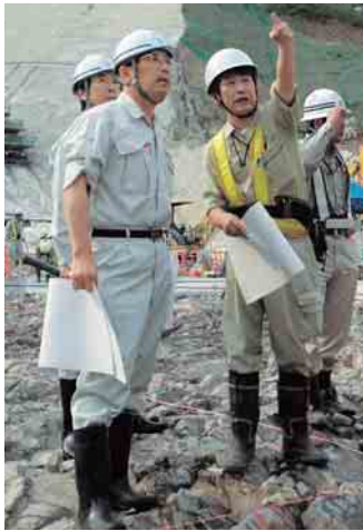
基礎岩盤の状態を検査する 木村事務所長(左)
