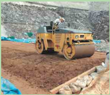
⑨ 振動ローラーで締固める コア材を敷きならした後、4トンの振動ローラーで締固めます。
