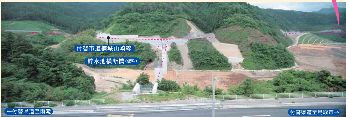
E 付替県道側から見た付替市道と貯水池横断橋(仮称)の進捗状況 (撮影:平成 21年6月)
