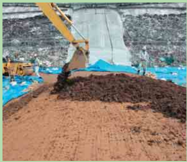
⑧ ショベルカーで土を敷く 凹凸がなくなったらショベルカーでコア材を敷いていきます。
