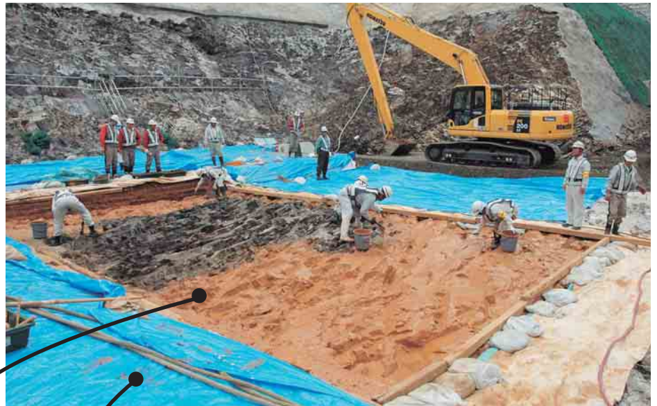
基礎岩盤にクレイスラリーを塗る様子 (撮影：H21年5月)
