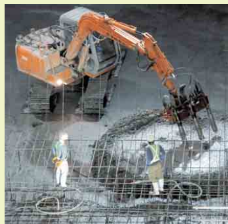
⑤ 大型のバイブレータでコンクリートを締固めます。
