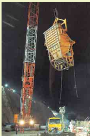
③ コンクリートバケットをクレーンで運びます。
