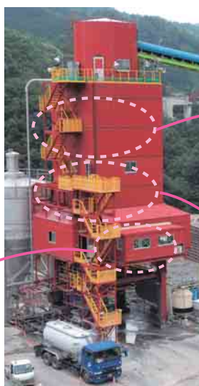
バッチャープラント
