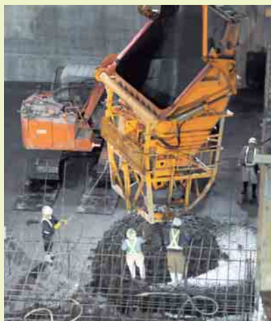
④ 打設箇所にコンクリートを降ろします。
