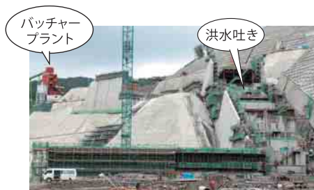
洪水吐き建設現場
