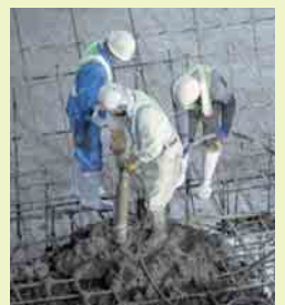
端部や大型の機械で施工できない場合は人力により締固めます。
