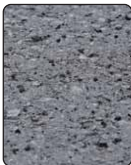
舗装路面のアップ
