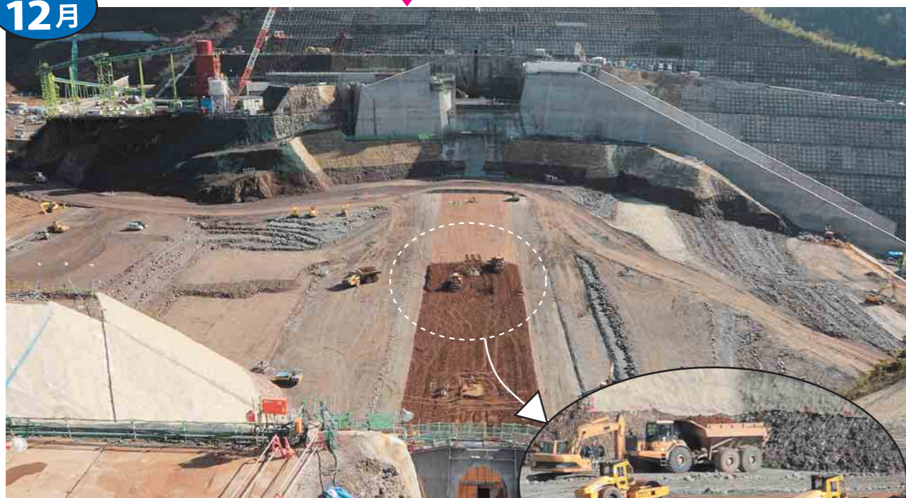
ダム堤体を盛立てる様子
