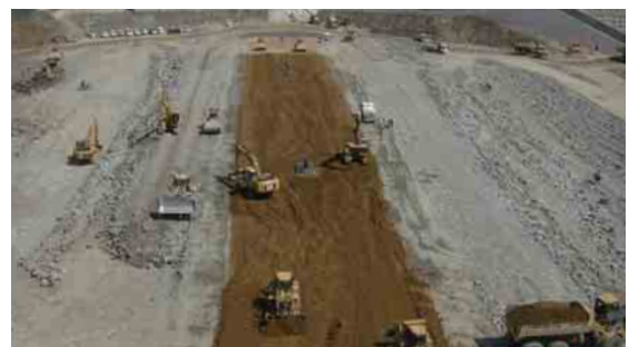
盛立て作業の様子 (撮影: H22年5月)
