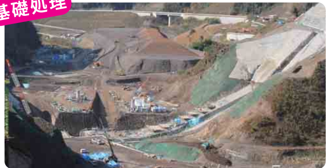
監査廊を設置する前段階の様子(撮影:H20年9月)
