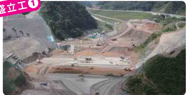
盛立て作業の様子(撮影:H21年9月)
