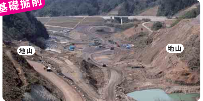
硬い岩盤まで地山を掘削する様子(撮影:H20年3月)
