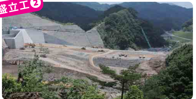
現在の盛立て作業の様子(撮影:H22年6月) 平成22年6月末時点で進捗状況は約7割に達しています。
