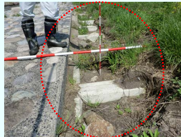
【千代川】 低水護岸法肩部の侵食 (堤防点検)
