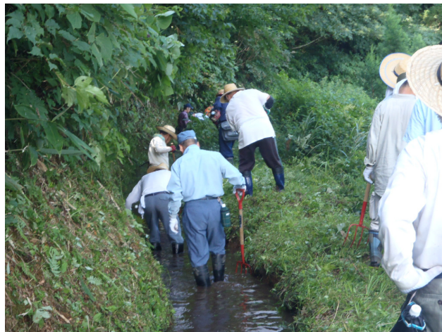
水路の中に入って清掃しています
