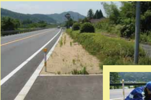
↑作業前の植樹帯
