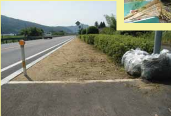
↑作業後の植樹帯
