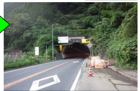
8月10日 仮復旧後
