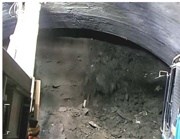
図-3 切羽崩落状況（TD=760m付）
