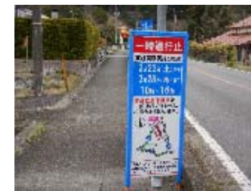
規制予告看板の設置状況
