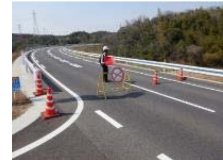
交通誘導員による通行規制実施状況
