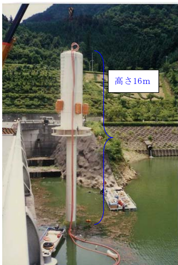
深層曝気施設
