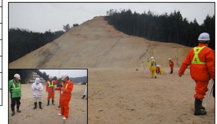
検査状況【実地】
