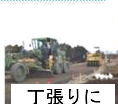
検測と施工を繰 り返して整形
