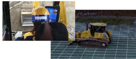
ICT建機による施工
