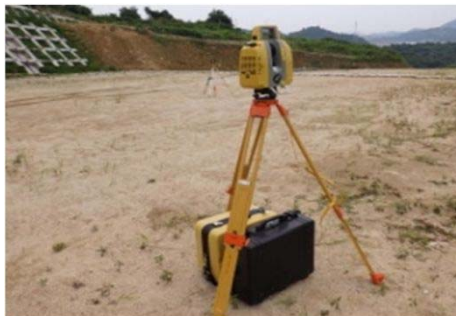
ICT建機による施工
