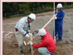
設計図に合わ せ丁張り設置
