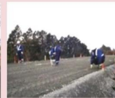
検測と施工を繰 返して整形
