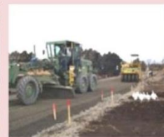
丁張りに合わ せて施工
