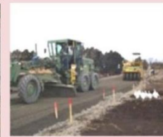
丁張りに合わせ て施工
