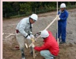
設計図に合わせ せ丁張り設置
