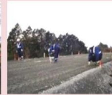
検測と施工を繰り 返して整形
