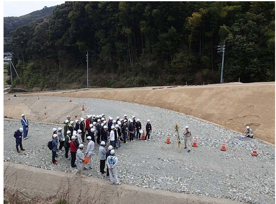
レーザスキャナーによる測量
