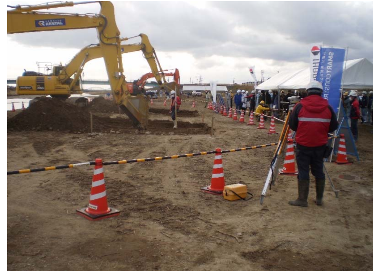
通常建機（手前側）ICTバックホウ（奥側）の施工性の違い等
