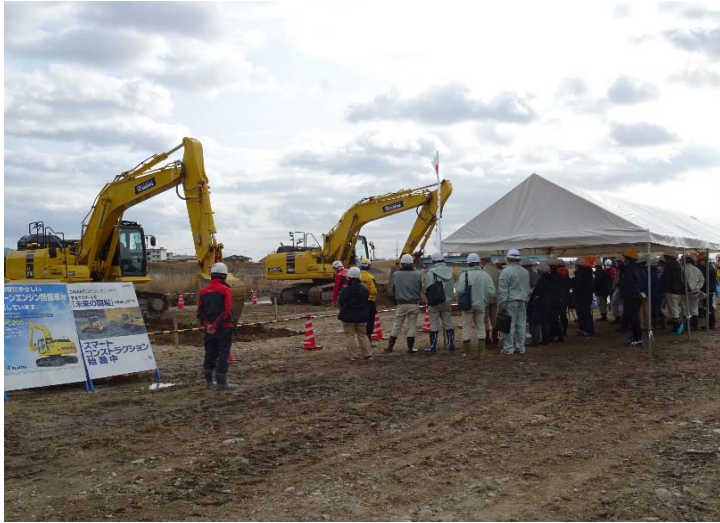
ICTバックホウ（右側）のデモンストレーション
