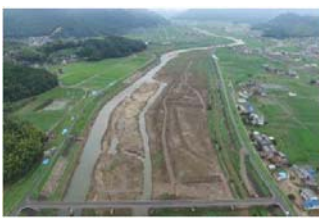
【樹木繁茂管理：初期状況】
