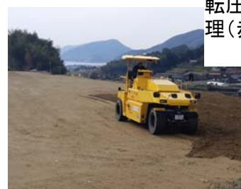
3次元MCブル ドーザーによる 施工
