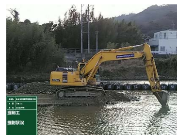
MCバックホウによる施工 (河床等掘削)
