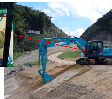
3次元設計データを 搭載したTS測量
