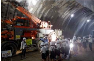
トンネル工事用大型機械を見学
