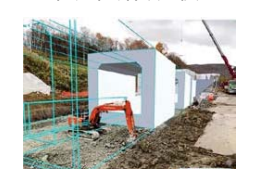
掘削作業時にARと比較
