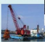
リアルタイムでの施工位置や出来形の可視化により施工管理を効率化
