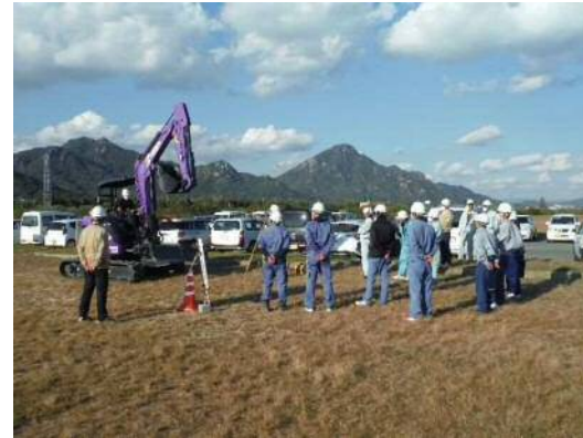
ITC建設機械 (ブレードマシンコントロール)
