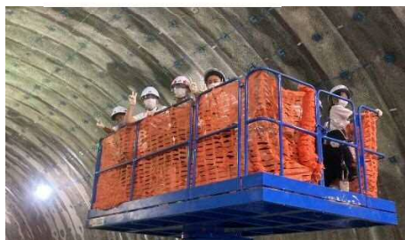
高所作業車に試乗
