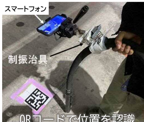
国内初のスマートフォン(AR)を用いたコンクリートの締固め管理
