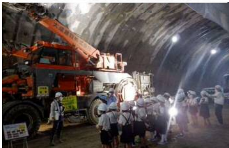
トンネル工事用大型機械を見学
